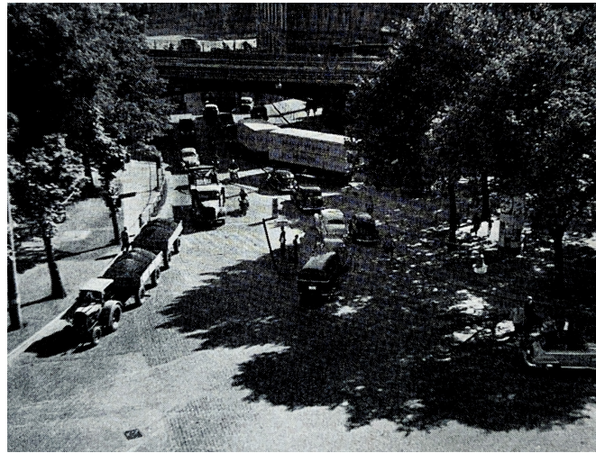
Abb. 43: Der Verkehrsknoten West vor dem Bau der Kennedybrücke (Tiefbauamt Hamburg, 1953)
