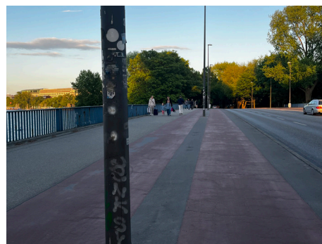
Abb. 63: Der nördliche Radweg auf der Brücke (eigene Darstellung)
