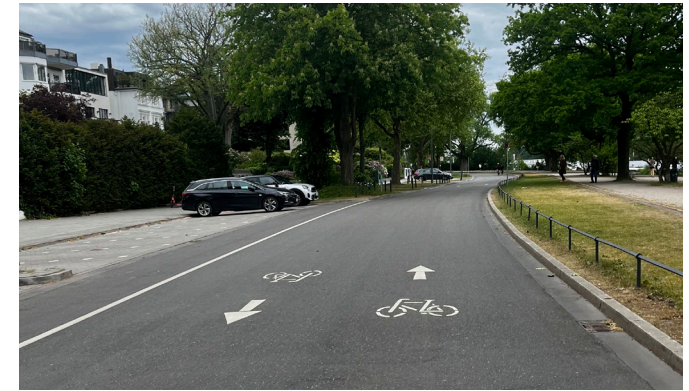
Abb. 50: Die Pilotstrecke am Alsterufer West (eigene Darstellung) West der Kennedybrücke. Aufgrund der nördlich des Abschnittes liegenden Umbaumaßnahme Hohenfelder Bucht kann erst nach Abschluss dieser Baustelle auch mit dem letzten Teil der Fahrradachse begonnen werden. Dort verläuft die Bestandsradverkehrs-führung auf mehreren Strecken beidseitig der Straße An der Alster: westlich der Straße am Alsterufer ist der Radweg für das Befahren in beide Richtungen freigegeben - aufgrund der teilweise sehr engen Führung ist hier jedoch ein hohes Konfliktpotenzial zwischen Fußgängerinnen und Radfahrerinnen gegeben. Im Rahmen einer Vorwegmaßnahme wurde daher die Nebenfahrbahn auf der östlichen Seite der Straße An der Alster im Jahr 2022 zu einer Fahrradstraße ausgebaut, um die Radverkehrslast auf beide Straßenseiten zu verteilen. In einem zweiten Schritt soll dann der Radweg auf der westlichen Straßenseite deutlich verbreitert werden, weitere Planungen oder Berichte sind jedoch noch nicht veröffentlicht worden. Ein veralteter Informationsstand der Stadt Hamburg spricht von einem Baubeginn im Jahr 2024, es ist jedoch aufgrund der Verzögerungen der Baumaßnahme Hohenfelder Bucht von einem Beginn nicht vor dem Jahr 2026 auszugehen (LSBG, 2022)..
